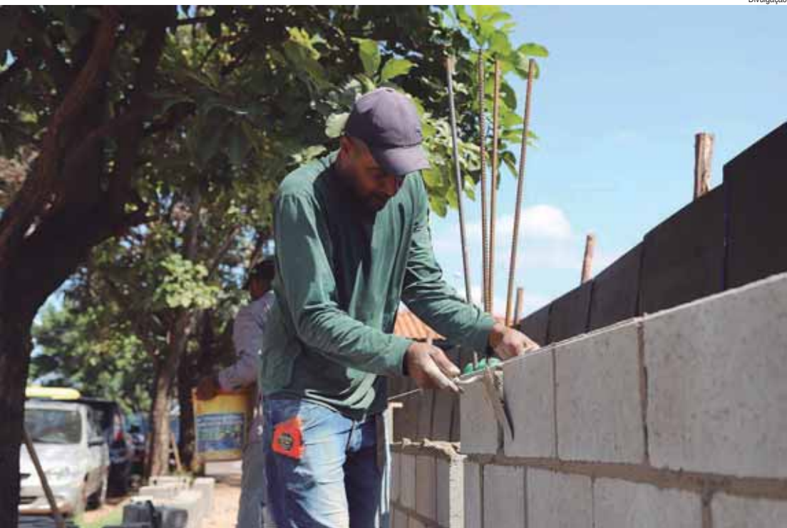
Com um investimento total de R$ 43,9 milhões, as unidades escolares recebem intervenções hidráulicas, elétricas e manutenções gerais
