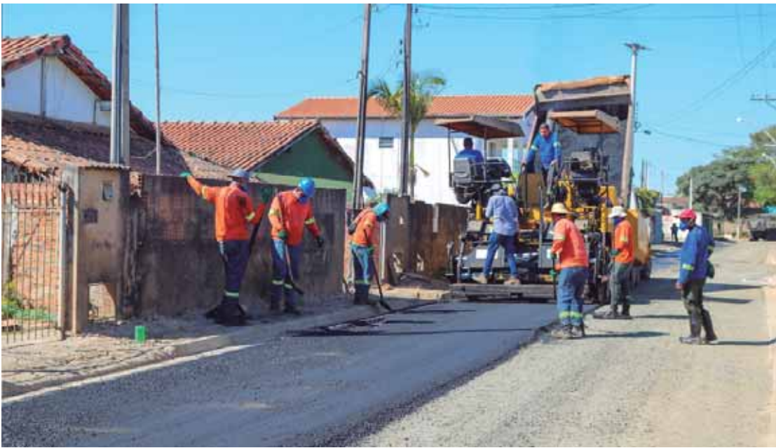
A equipe está executando a camada de ligação, com aplicação de material para dar aderência à massa asfáltica
