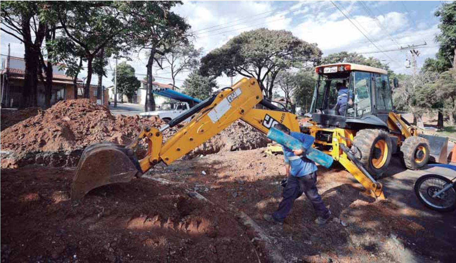
Semae finalizou ontem, 12-07, troca de rede de água na avenida Cristóvão Colombo
