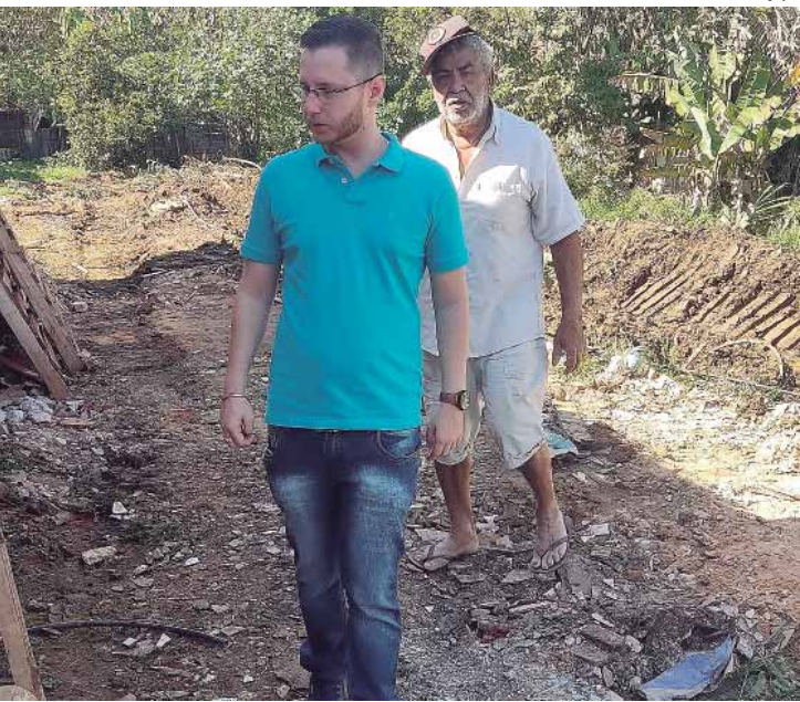
Vereador Gustavo Pompeo fiscalizou o andamento do serviço feito pela Defesa Civil
