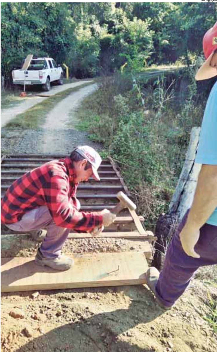
Equipe da Sema faz manutenção de mata-burro no bairro Morro Preto
