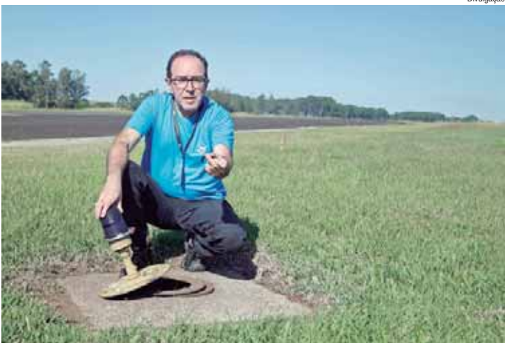
Marcelo Kraide, diretor do Aeroporto Municipal Pedro Morganti, mostra balizamento que será trocado
