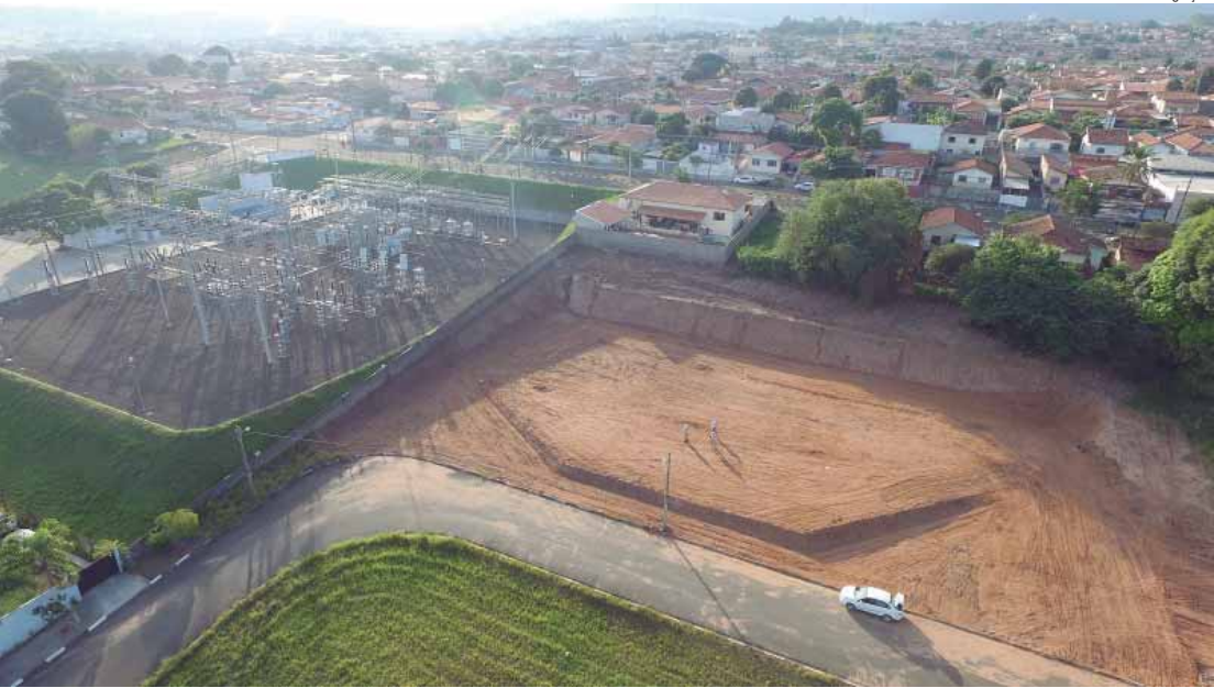
Área em que será construída nova subestação em São Pedro
