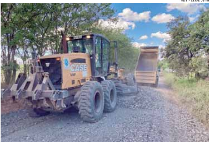
Manutenção na estrada principal do bairro Santa Isabel
