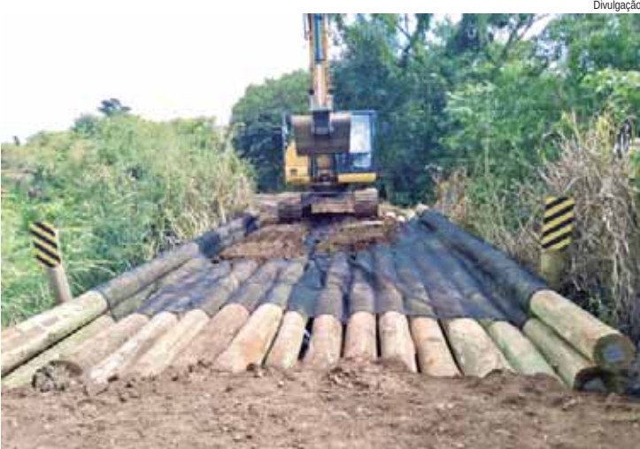
Reparo de ponte de madeira no bairro Monte Branco; serviços foram realizados de 8 a 12/05
