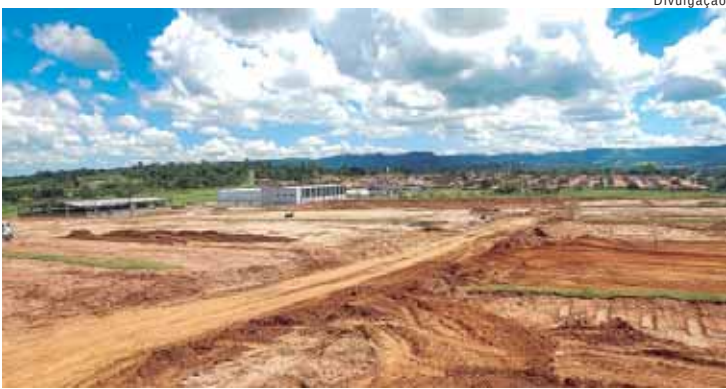
Novas instalações no Distrito Industrial vão gerar 350 empregos diretos
