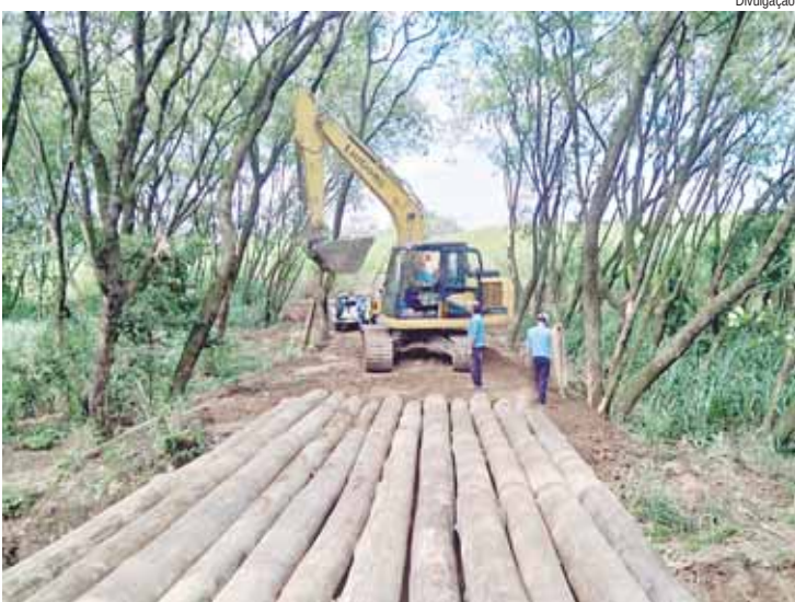
Reparos na ponte do Cera, na região rural do bairro Santa Teresinha: cinco bairros receberam as melhorias nesta semana
