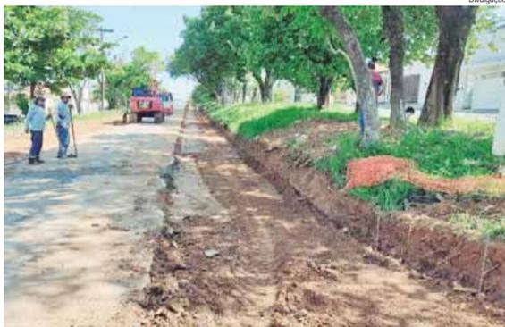
Até o momento, a Semozel já executou adequações na galeria de águas pluviais, com instalação de rede e colocação de tubulação, além de reforma de bocas de lobos
