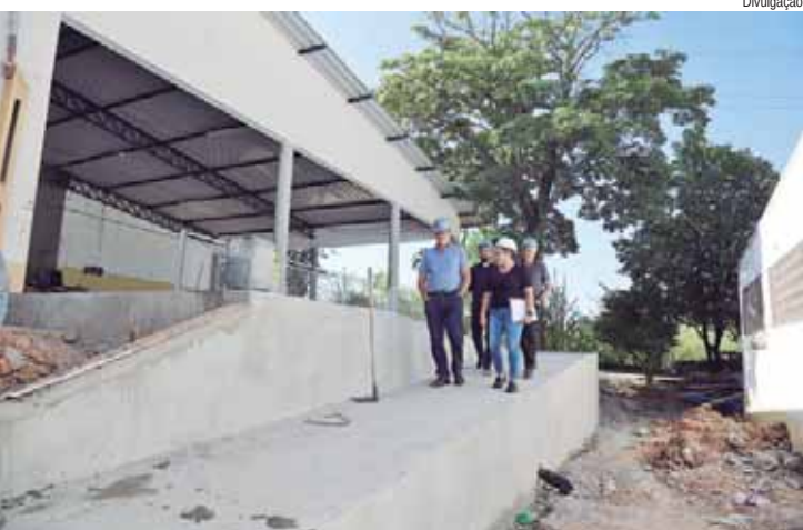
As obras de restauro e manutenção da EM Bruna Ferreira da Silva, localizada no Jardim Alvorada, atingiram no início deste mês de abril 27 de execução do cronograma de intervenções
