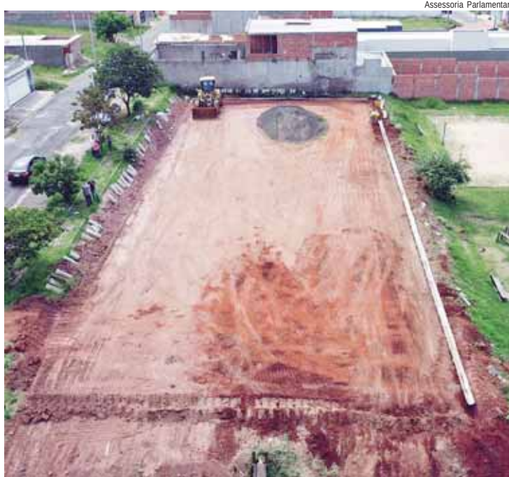
Paulo Henrique (Republicanos) esteve na tarde desta terça (28) na rua Aparecida Augusto, onde o centro esportivo está sendo construído
