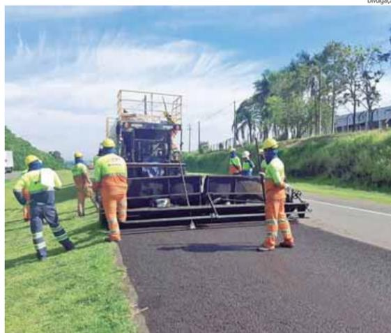
Eixo inicia em trecho de Piracicaba aplicação de material novo que tem em sua composição fresagem de asfalto
