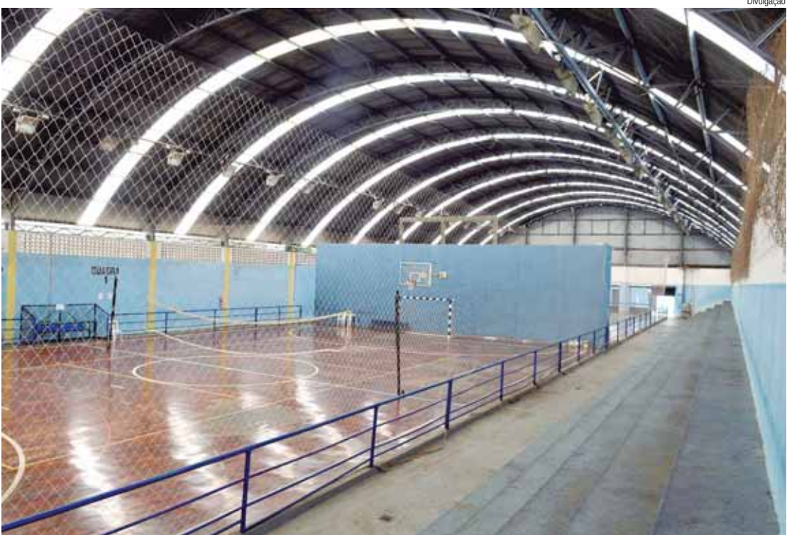
O mini ginásio Garcia Neto terá o telhado das quadras reformado
