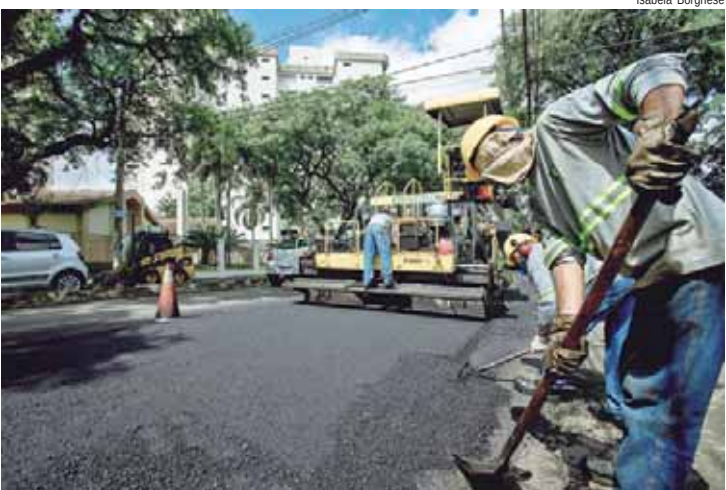
Avenida Presidente Kennedy já teve o recape concluído
