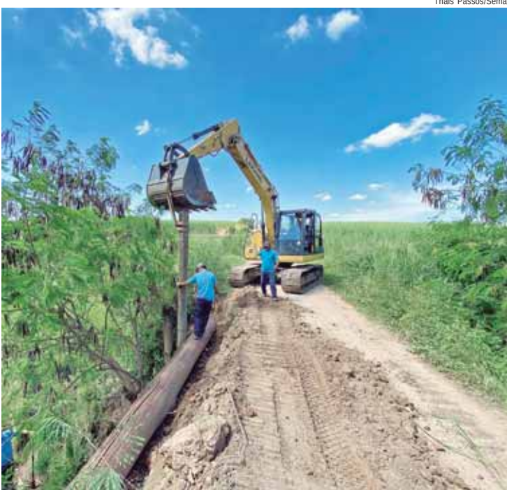
Manutenção em ponte no bairro Almeida
