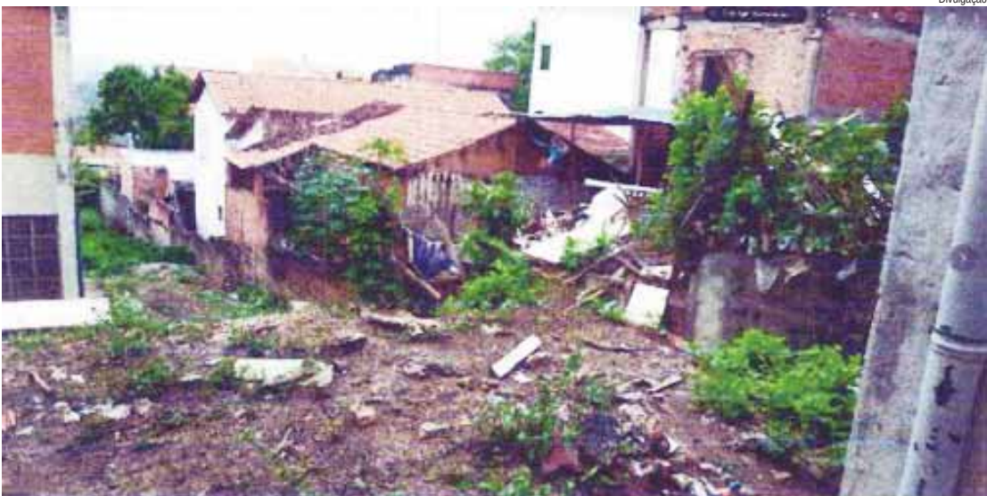
O pedido para a liberação do recurso é para a construção do muro separando a escola das demais casas
