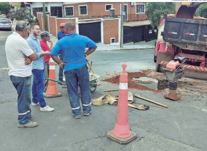
Gustavo Pompeo acompanhou nesta quinta-feira (16) a obra de revitalização das galerias pluviais na avenida Cristóvão Colombo
