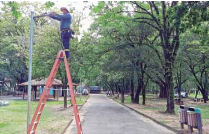
Ao todo, serão retiradas 34 luminárias do tipo vapor metálico para instalação de outras 34 novas luminárias de LED
