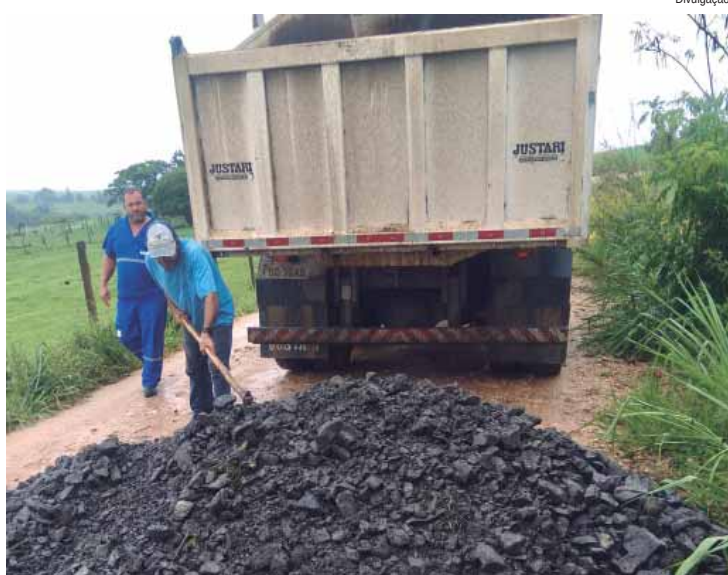
Equipe tapa buraco com aplicação de lajão britado no bairro Almeida
